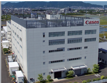
キヤノンマシナリー株式会社 滋賀県草津市
